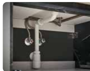
升級隱藏式排水管
